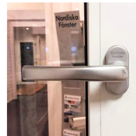
Med handtagets position till 90° öppnas fönstret helt, inåtgående.
