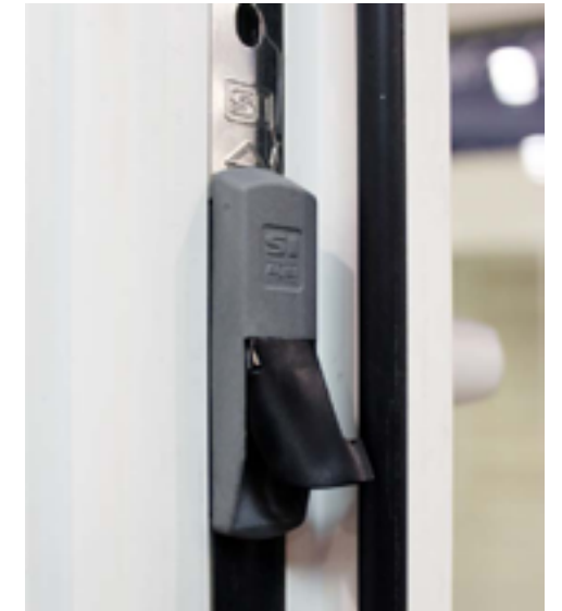
1. Handtagsspärr. Finns på spanjoletten i höjd med handtaget.
