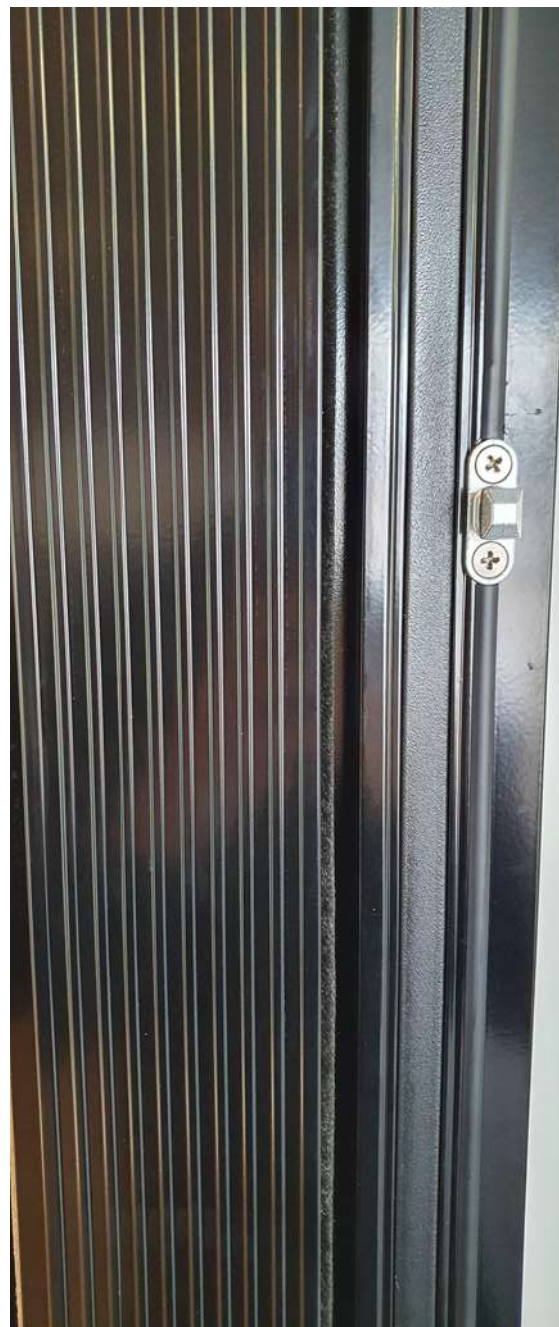
Karmsida vid öppningsbar del.
