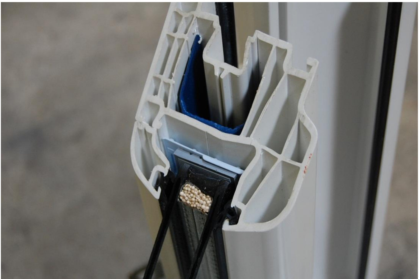
Rundad profil i genomskärning Foto: Nordiska Fönster
